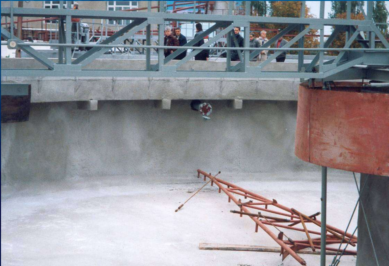
Reparacion de grietas utilizando Xypex Concentrado y Modificado
