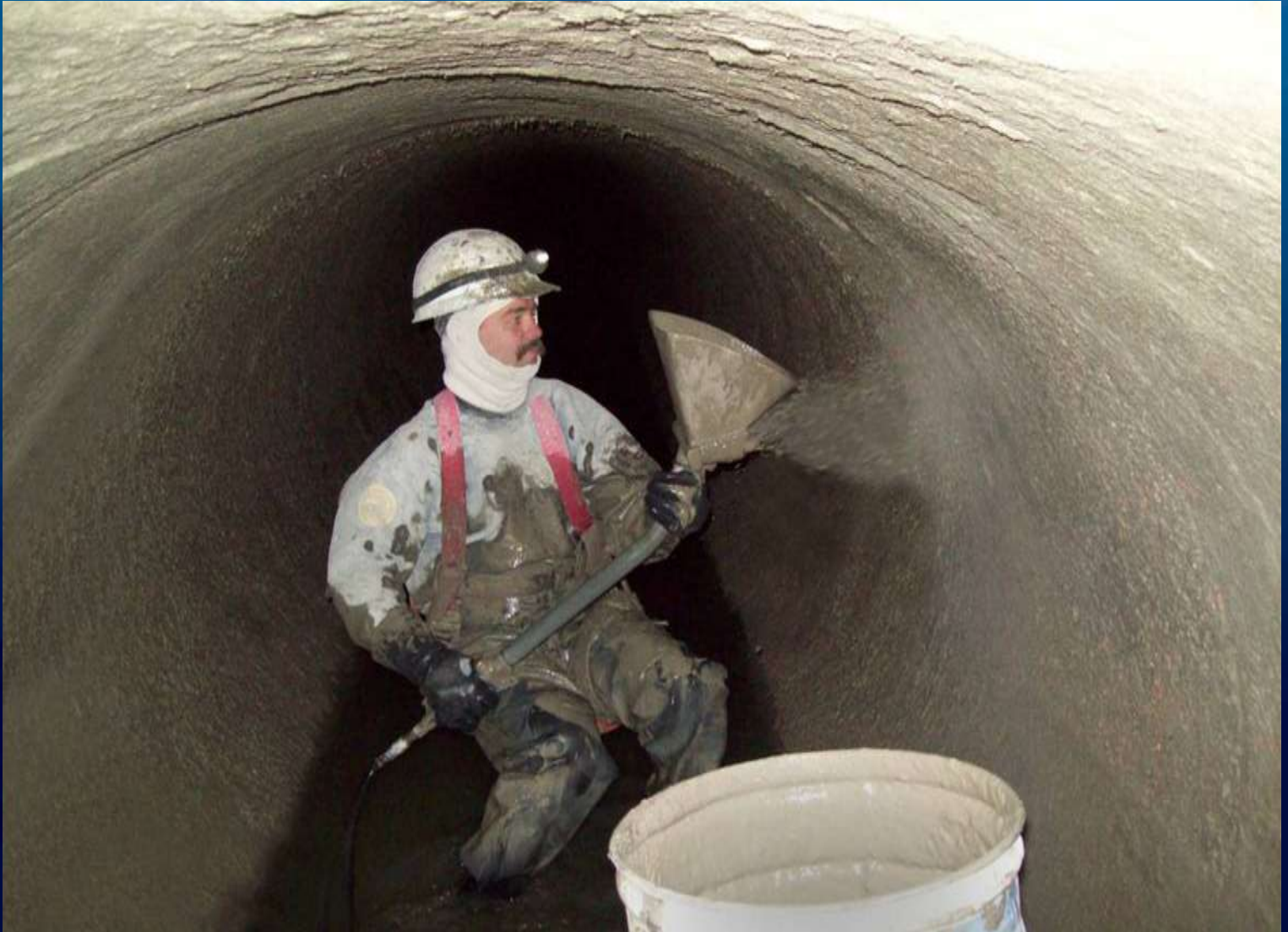
700 metros fueron rehabilitados utilizando una capa de concentrado luego una capa de Megamis I
