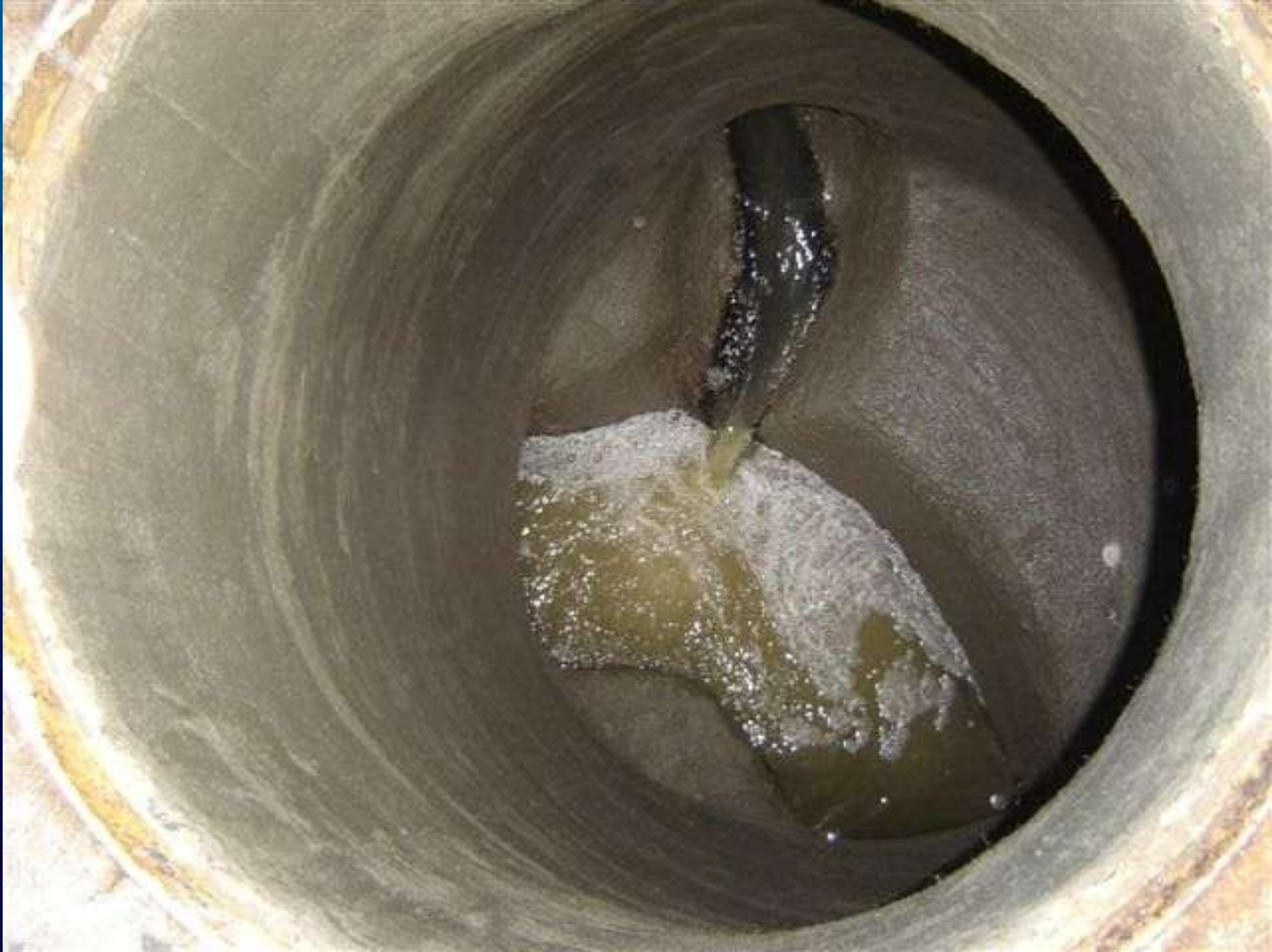
Ocean Grove Sewage System, Australia . Reparacion de manholes con Xypex Megamix
