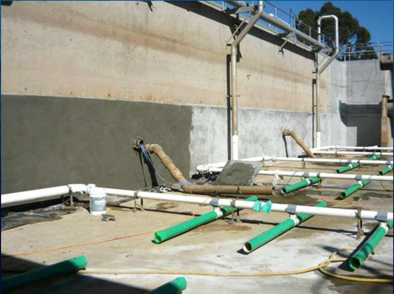
La planta se rehabilitó utilizando Xypex Concentrado y Modificado
