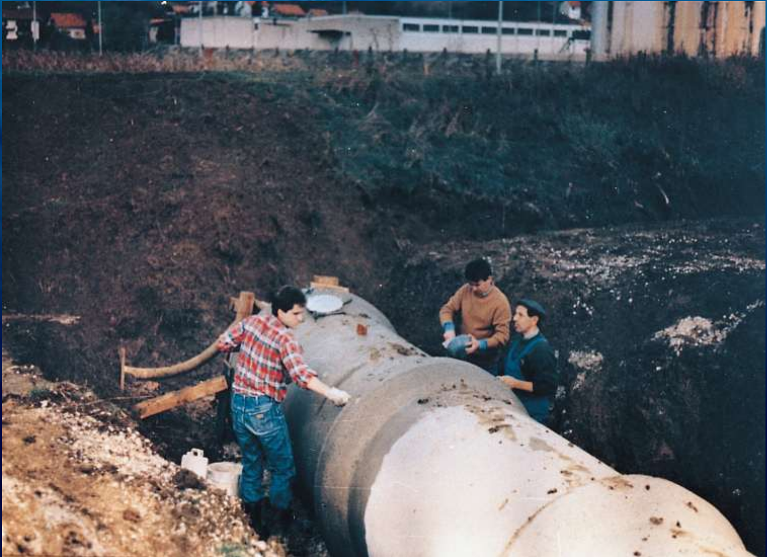
Reparacion de juntas con Patch n Plug y Concetrado
