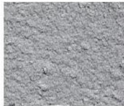
CSP 5 (medium shotblast)
