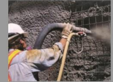
Concreto lanzado (Admix)
