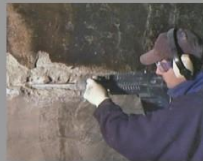
Rehabilitación (Patch'n Plug & Megamix)
