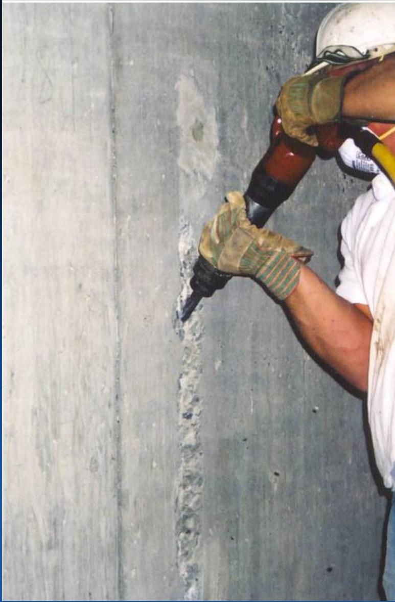
Cortar o picar grietas, juntas frías o de construcción y otros defectos estructurales a una profundidad de 25 mm y un ancho de 25 mm. hasta formar una ranura en forma de “U”
