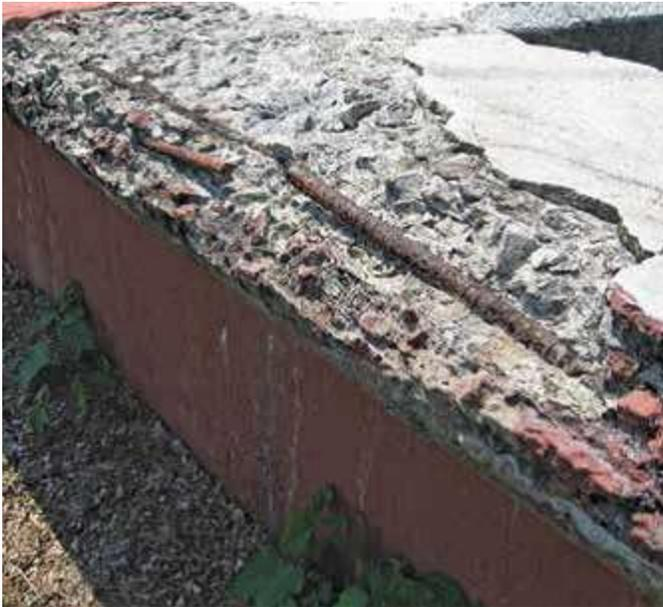
A pesar de todas las ventajas que ofrece el concreto, su naturaleza porosa permite la permeabilidad de líquidos y gases, y en consecuencia, es susceptible al deterioro causado por la penetración del agua y del ácido producido por el gas sulfato de hidrógeno ( $H_2S$ ) en las alcantarillas, poniendo en riesgo la integridad de la estructura.
